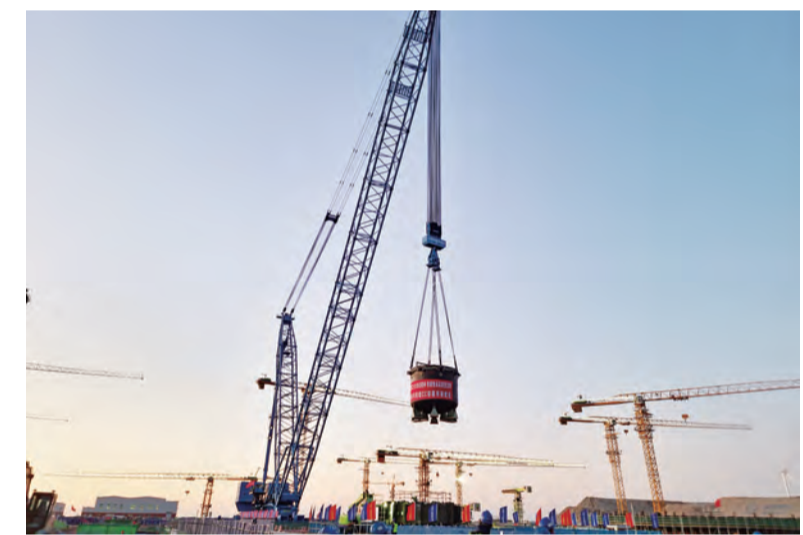
近日,徐大堡核电站4号机组堆芯捕集器壳体容器顺利吊装就位。本次吊装的堆芯捕集器壳体容器位于堆芯竖井底部,是核电站安全的重要保障,也是堆芯竖井内的大型设备之一。(何讯)
