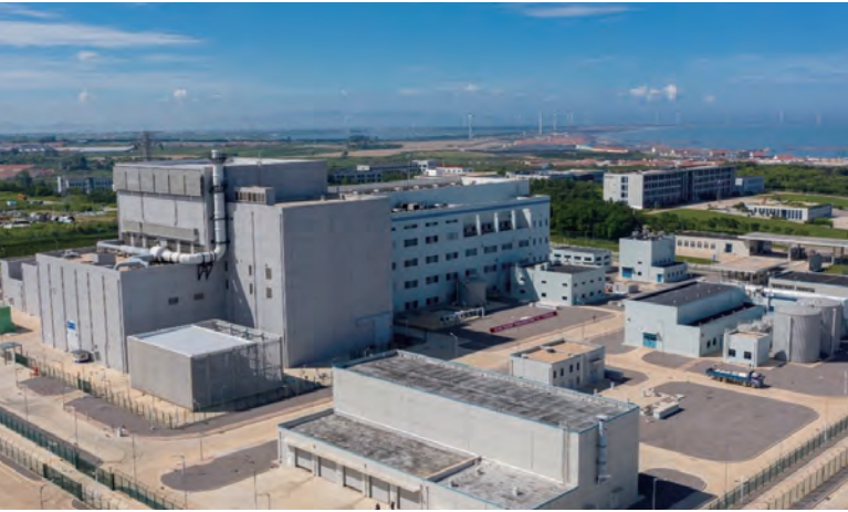
石岛湾高温气冷堆示范核电站
